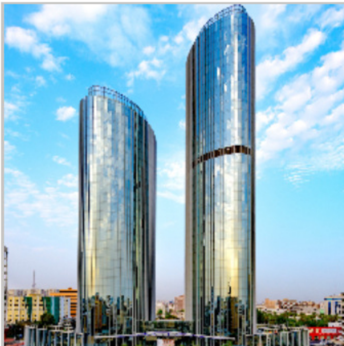
BAYYAT PLAZA , JEDDAH
