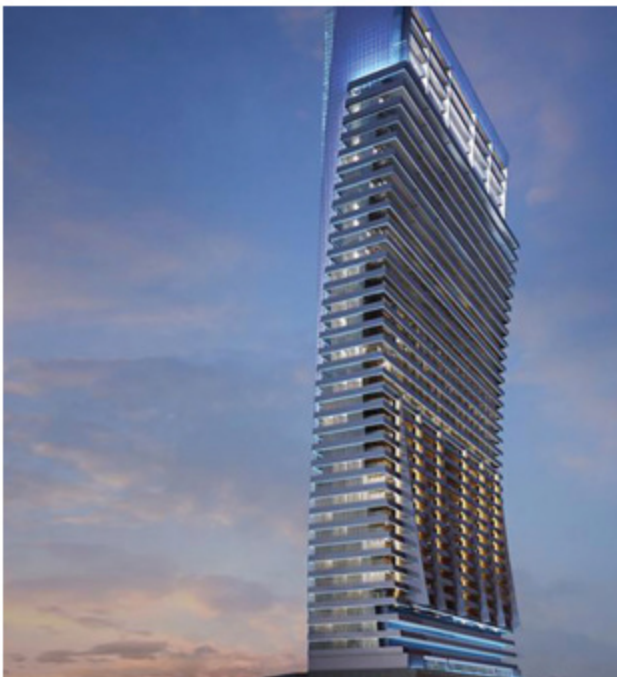
JAWAHRA TOWER , JEDDAH
